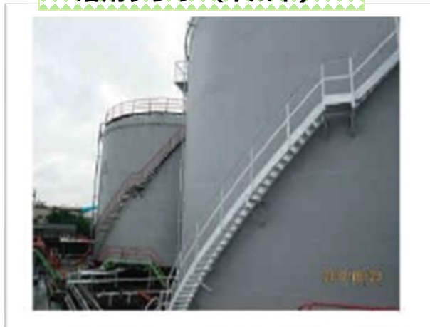
溶剤タンク (市川市)
