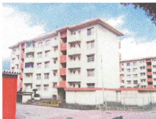
約8年前に施工。 建物本体は熱交換塗料塗布。 集会場(白い建物)は、一般塗料塗布。
